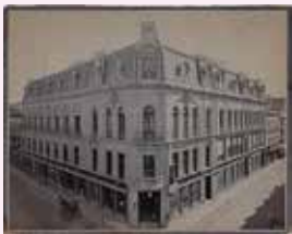
33. Edificio del Centro Histórico
